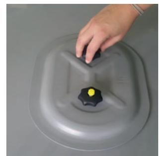
Appliquez le gabarit autocollant fourni avec la trappe sur la paroi du conduit.
